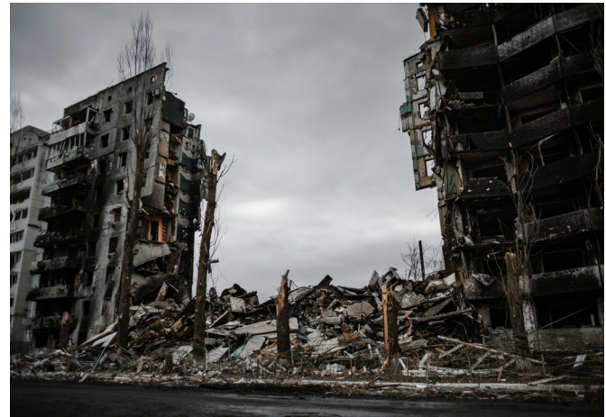
Zerstörung in Kiew nach Luftangriff
